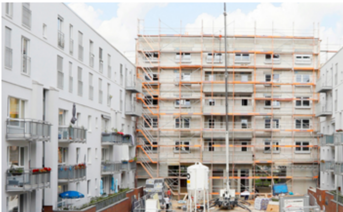
Direkt unter dem Frankfurter Fernsehturm werden 300 Wohneinheiten in KfW 70-Bauweise mithilfe von JB-D/FA PLUS realisiert, dem Befestigungssystem von SFS.
