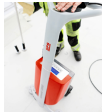
Schweißgerät: Abschließend wurden die Lastverteiler mithilfe des eigens zu diesem Zweck entwickelten Induktions-schweißgerätes isoweld® 3000 rückseitig mit der Abdichtung verschweißt.
