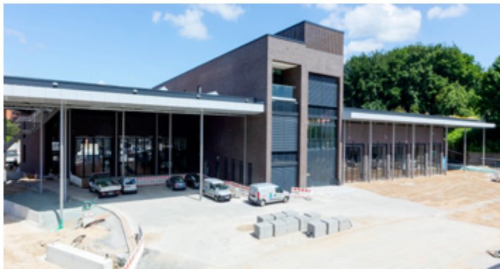
Busbetriebshof Kiel: Die Kieler Verkehrsgesellschaft (KVG) gestaltete ihren Betriebshof an der Wertstraße um. Die Entwürfe des Hamburger Architekturbüros agn Leusmann, das hier als Generalplaner fungierte, wurden dabei besonders auf die technischen Anforderungen umweltschonender Hybrid- und Elektrobusse abgestimmt.
