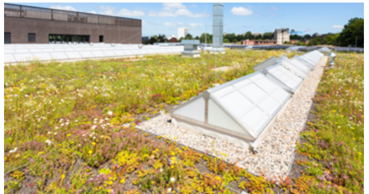
Fertigstellung: Da auch die Zusammenarbeit der einzelnen Gewerke erleichtert wurde, ermöglichte das durchdringungsfreie Feldbefestigungssystem isoweld® von SFS die schnelle und sichere Ausführung des Flachdachaufbaus für die neue Werkstatthalle.
