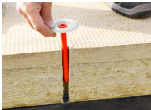
Lastverteiler mit Tülle: Bei der Montage wurde die auf den Untergrund und die Dachbahn abgestimmte Kombination aus Befestiger, robuster Kunststoff-Tülle FI-R-20 sowie Lastverteilern durch die Wärmedämmschicht verschraubt.
