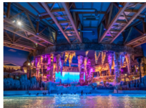
Die muschelförmige Flachdachkonstruktion der 32.600 Quadratmeter großen Wasserwelt wird von fünf 87 Meter langen Holzbindern getragen.
