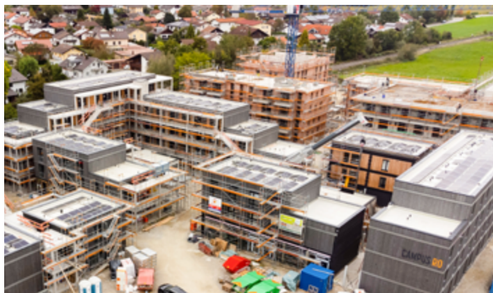
In unmittelbarer Nähe zur Technischen Hochschule Rosenheim entstand das Studenten-Quartier CampusRO.
